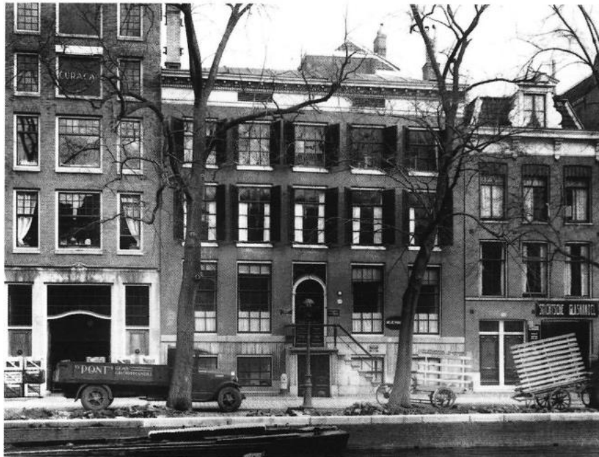
Wilhelminahuis - Kantoor NFGV*
